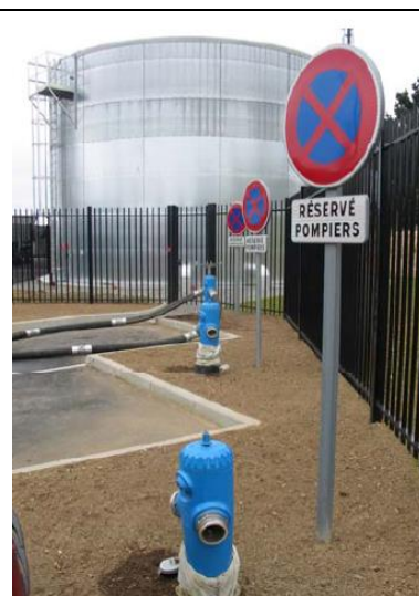
Réserve aérienne équipée de 3 poteaux d'aspiration de 150 mm
