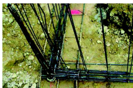
Nœud de chaînage - Continuité mécanique
