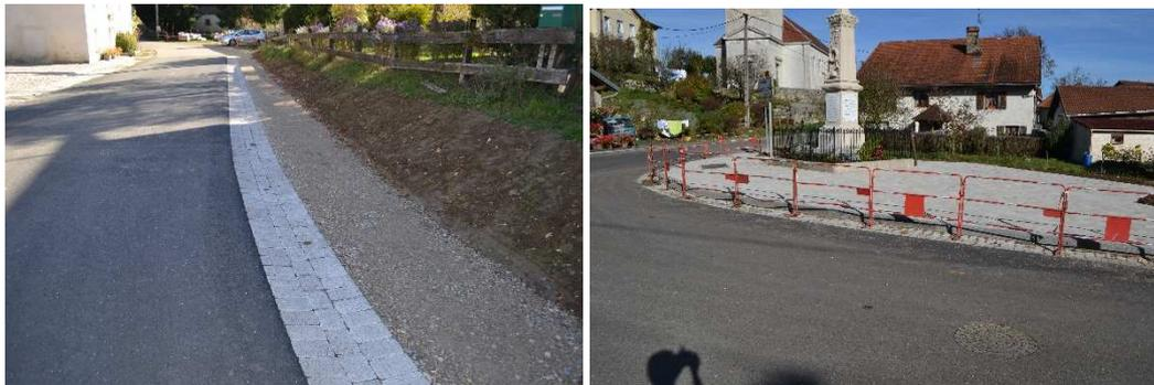
Figure 36 : Illustration des travaux de réfection de chaussée – Réalisation DORGAT
